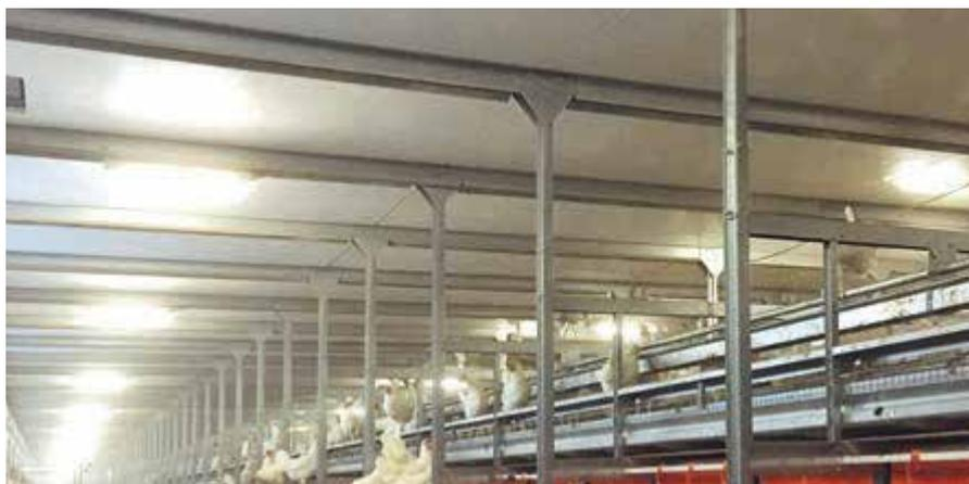
A superfície branca e lisa da parte inferior dos painéis plásticos permite o fluxo de ar fresco no sentido transversal por todo o galpão, sem obstruções
