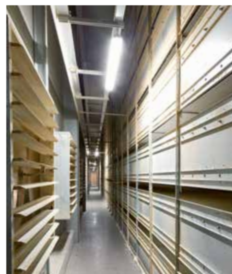
Corredor de pressão com pressão positiva de aproximadamente 25 Pa.
