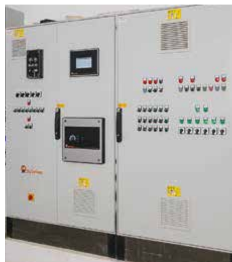
O ViperTouch (integrado ao painel de controle) controla o sistema.
