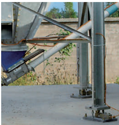
Pesagem do silo
