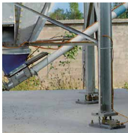
Pesagem do silo
