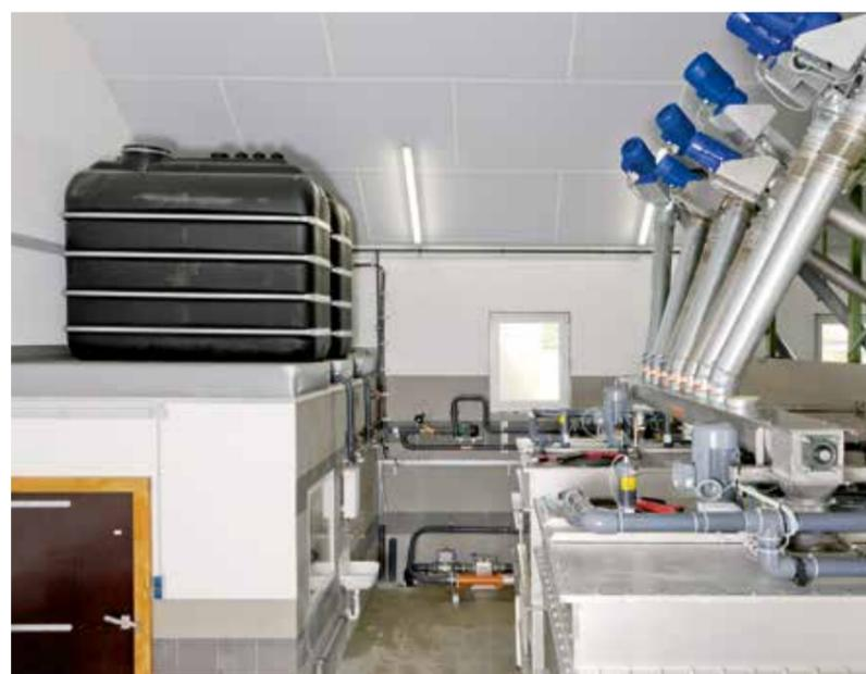
Cozinha de Alimentação com tanques de mistura e um tanque com 2.000 L de água limpa
